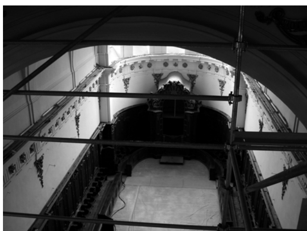
Figure 4 : Vues extérieure et intérieure de l'église Saint-Bruno des Chartreux à Lyon montrant les travaux de restauration coordonnés par l'association Saint Bruno splendeur du Baroque (Source, Auteurs, 2008).
