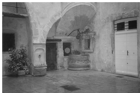
Figure 3 : Les traboules du Vieux Lyon dans un état dégradé (à gauche) et après les travaux de restauration (à droite) auxquelles a fortement contribué l'Association Renaissance Vieux Lyon (Source, Auteurs, 2008).
