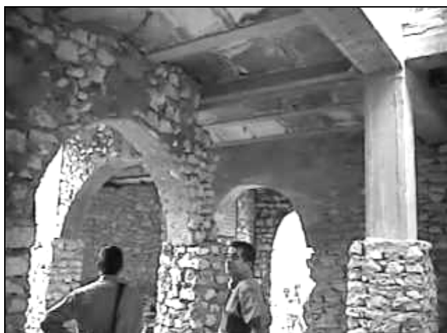
Figure 2 : Les travaux menés dans le but de sauvegarder la Casbah de Ouargla et auxquels a participé l'association Casbah ont touché les espaces extérieurs et intérieurs de l'ancien noyau de la ville (Source, Auteurs, 2008).
