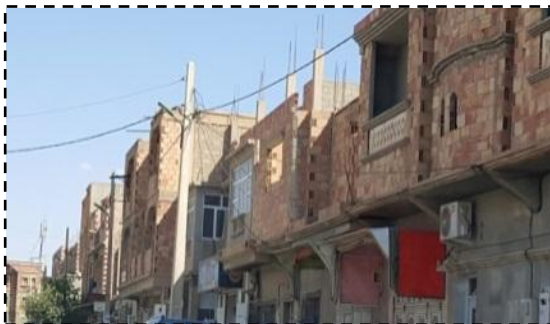
الصورة رقم 02: بنايات غير مكتملة المصدر: الباحث 2017
