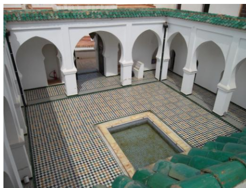
Figure 06: L'effet sensoriel lumineux de la cour centrale est caractérisé par la radiosité (Auteurs, 2016)
