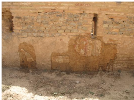
Figure 06: trous des passages de conduites aménagés derrière les piscines froides
