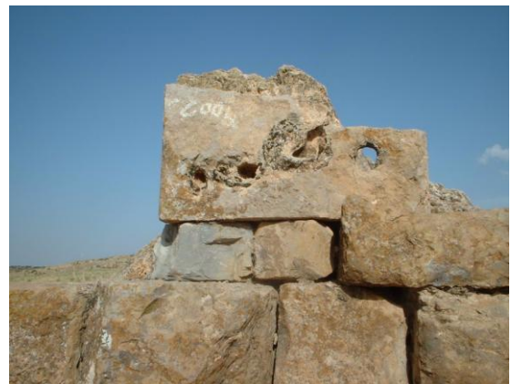
Figure 05: Pile terminale de l'aqueduc, une partie du bassin répartiteur avec les trous de différents diamètres
